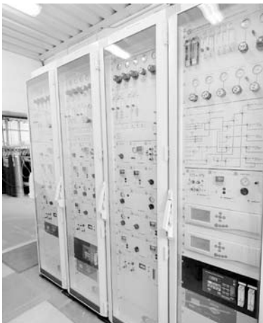
Cabinets d'analyse pour gaz Ultra haute pureté N 2 , O 2 , H 2 , Ar et Air sur le site Gaz Spéciaux d'Air Products à Keumiée, Belgique
